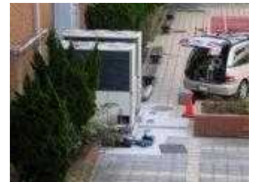
〔室外機設置工事〕
