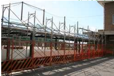
【工事中の渡り廊下】
